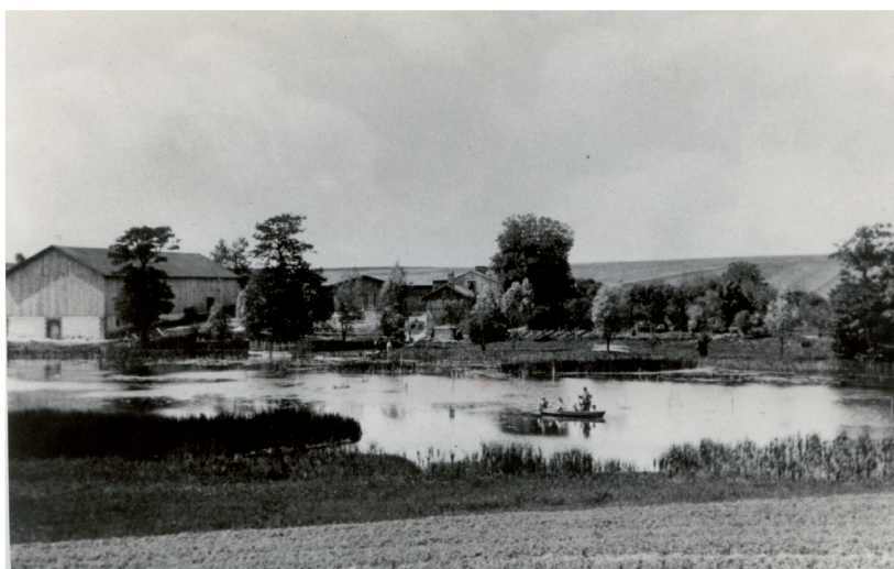
Das untere Sietzenhütte, vom oberen Sietzenhütte aus fotografiert. Rechts ist der Weg über die Brücke. Foto von 1894
