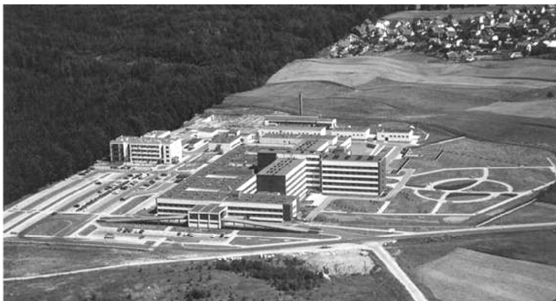
Hospital in Koscierzyna: Luftaufnahme; Idyllisch gelegen nordwestlich der Stadt.
