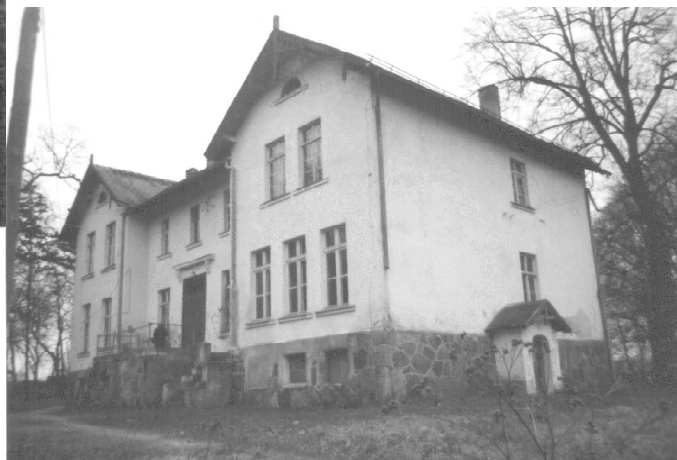
Gutshaus Groß Mierau Süd-Ost-Seite 1999: der Verfall innerhalb von fünf Jahren ist evident.
