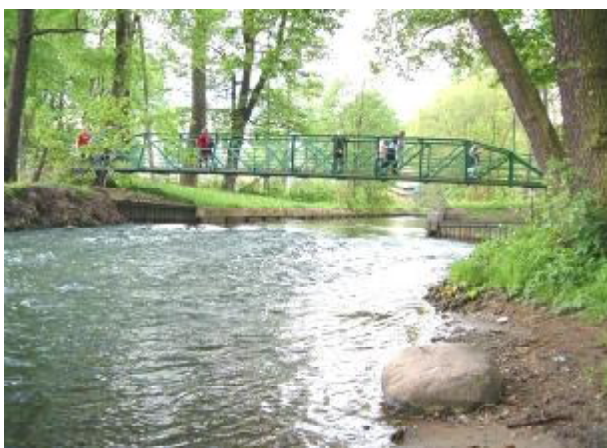
Fußgängerbrücke über die Fietze in Schöneck
